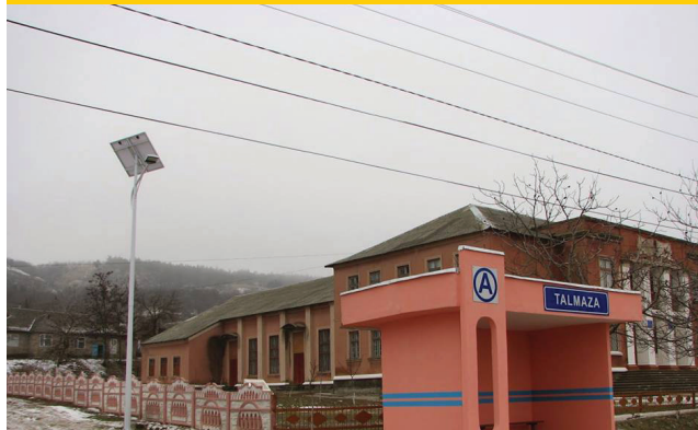
6 sisteme de iluminat stradal cu emisii reduse de GES instalate în satul Talmază
