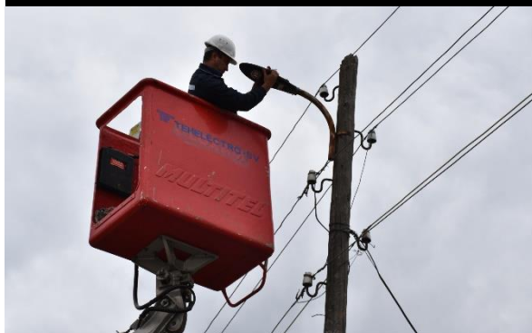
Demontarea becurilor vechi de pe străzile satului Palanca și montarea a 164 becuri de tip LED
